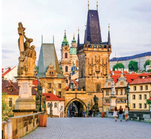
Puente de Carlos (Praga)
