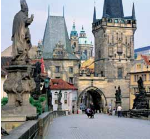
Puente de Carlos (Praga)
